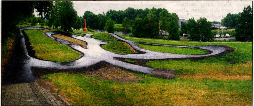
**60 Tonnen Asphalt sind auf die alte BMX-Bahn aufgebracht worden. Als Restarbeiten müssen nur noch die Ränder angeglichen werden**
